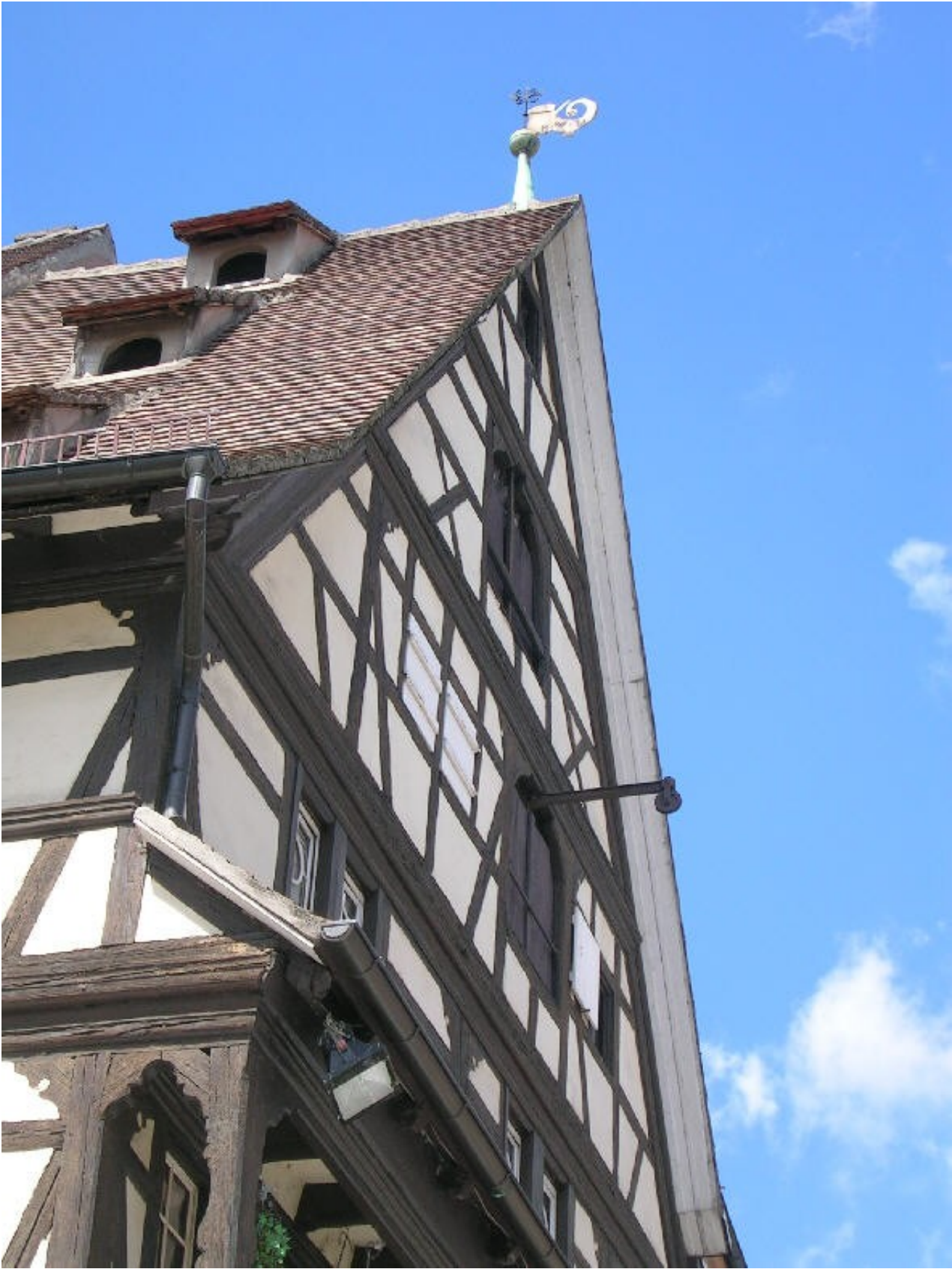
ANNEXE N°4 : Photo du pignon du bâtiment
