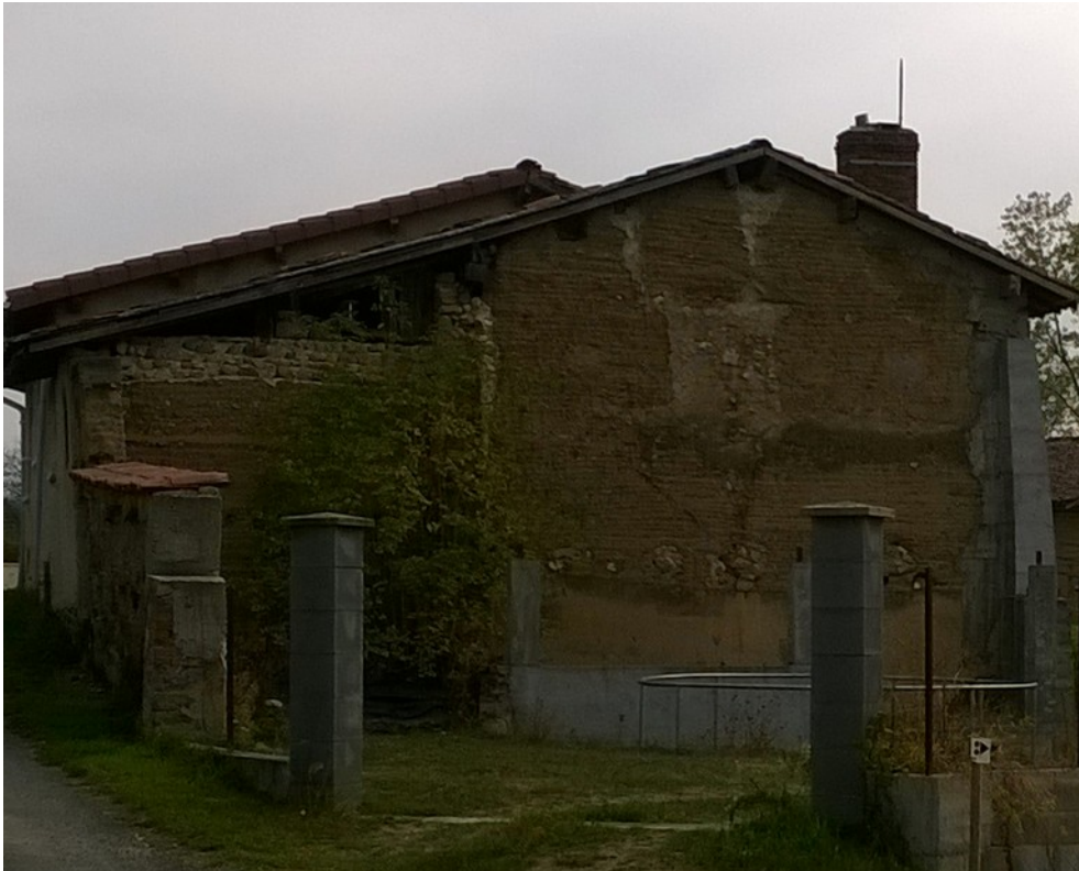
Mur en pisé à Boerias
