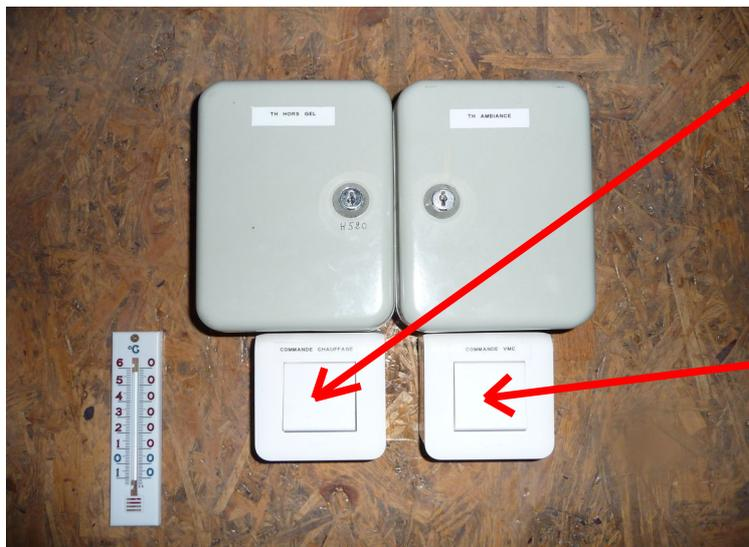
Appuyer sur le bouton **COMMANDE CHAUFFAGE** pour une période de **3 h de chauffage** pour la partie grande salle.
